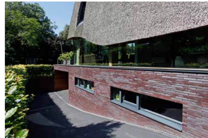
Een met metselsteen bekleedde betonnen bak, een glaslaag en een rieten hoed vormen samen één geheel.
