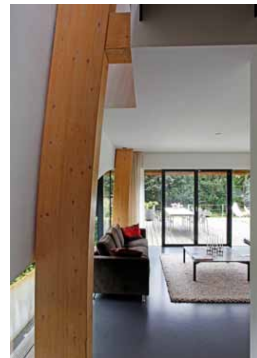
De spanten verjongen, lopen smaller toe, om ze een slanker uiterlijk te geven.
