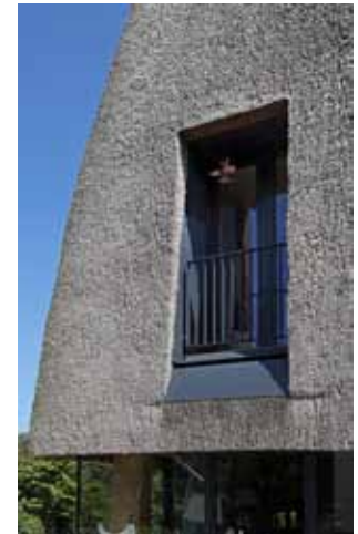
Ramen vallen perfect en eenvoudig weg in dit dakbekledingsmateriaal.
